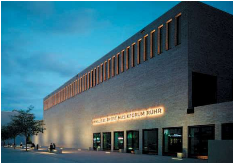
Anneliese Brost Musikforum Ruhr, Bochum Progetto architettonico di / Architectural design by Bez+Kock Architekten Generalplanner GmbH Illuminazione con apparecchi BEGA / Lighting with BEGA Luminaires
